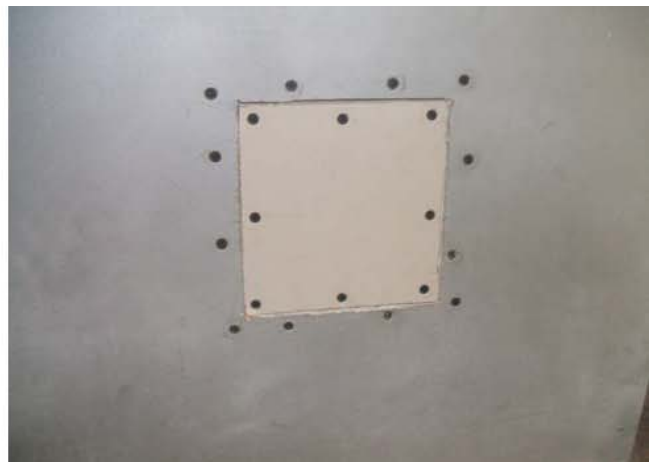
Figura 4. Aplicar Parche de Placa de Yeso
