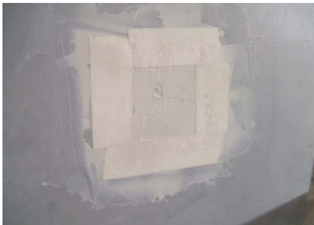
Figura 5. Aplicar Cinta y Acabar el Área con Parche
